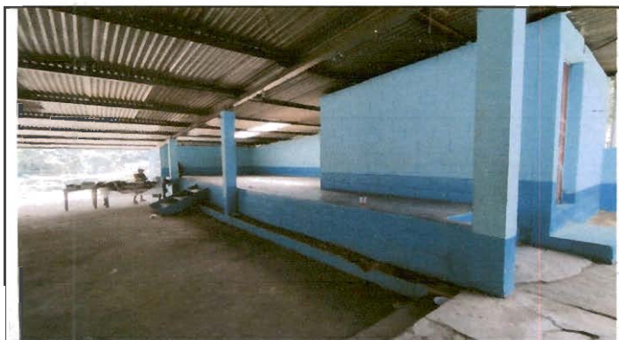
Foto 3: Sustitucion de elementos de fijacion
