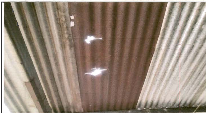
Foto 1: Sustitucion de lamina, por lamina troquelada aluzincn calibre 26
