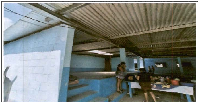
Foto 5: sustitucion de canal de metal
