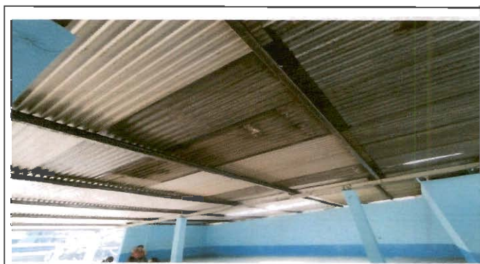
Foto 4: Sustitucion de bajada de agua pluvial de metal por tubo PVC 3"
