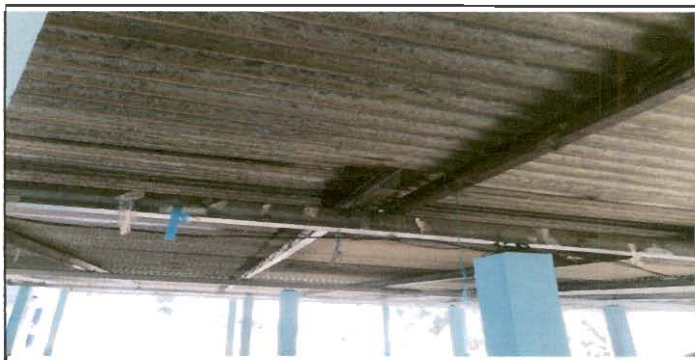
Foto 6: Sustitucion de estructura de soporte de metal, por metal
